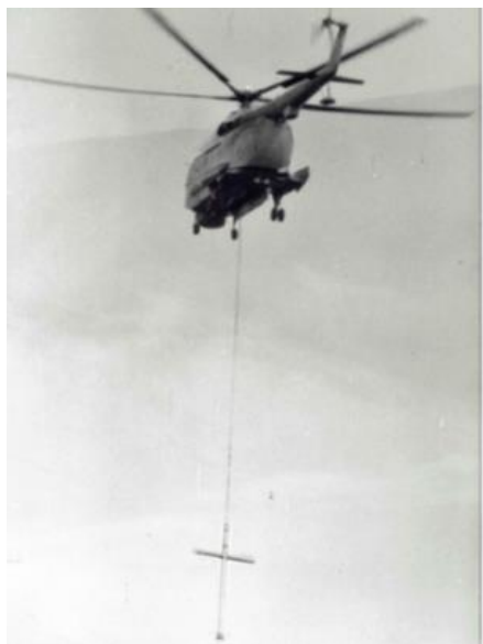
Dwa przykłady wykorzystania śmigłowców LMW w roli latających dźwigów. Z lewej: Mi-14PS ustawia krzyż na wieży kościoła parafii pw. Podwyższenia Krzyża Świętego w Rumi, sierpień 1991r. Zdj. kronika parafialna Po prawej: W-3RM ustawia klimatyzatory na budynku centrum handlowego w Gdańsku, sierpień 1998 r. Zdj. Miłosz Rusiecki
