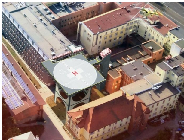
Rys. 24. Ładowisko Gdańsk - Nowe Ogrody. zbudowane na platformie na wysokości sąsiednich dachów [16].
