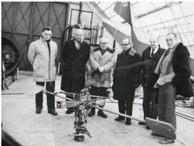
Zespół inicjatorów odbudowy zniszczonego SP-GIL.
