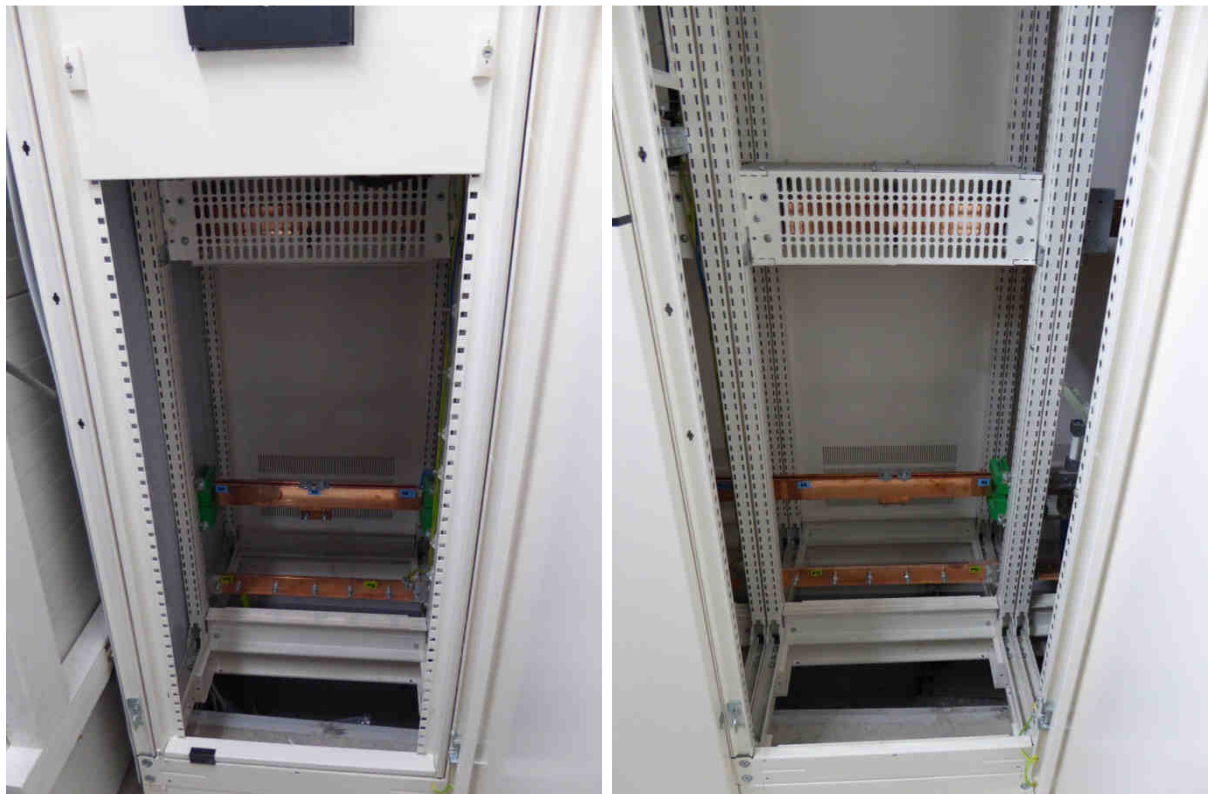
Rysunek 7 Pola rozdzielni nN przeznaczone na zabudowę aparatów na potrzeby instalacji sterowania laboratorium.
