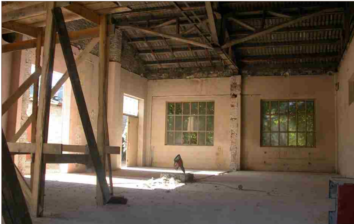
Remont pomieszczeń w budynku H3
