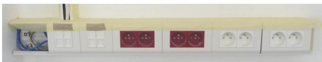
Rysunek 5 Przykładowy zestaw gniazd zamontowanego w listwie naściennej
